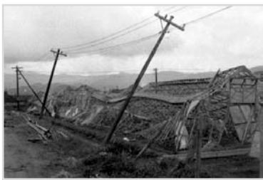
台風 23 号による被害(旧武生市) 昭和 40 年 78473
