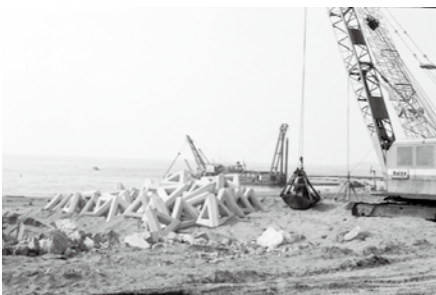
昭和47年 福井新港建設着工
