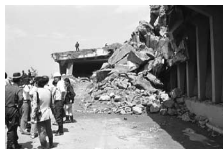
平成元年 越前町国道305号がけ崩れ事故
