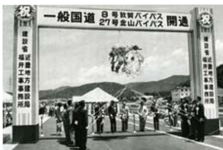
昭和62年 敦賀・金山バイパス開通
