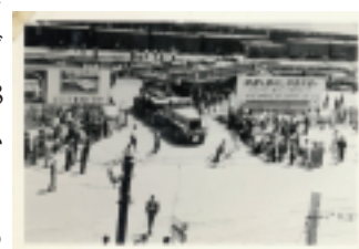
▲「輸送作業記録写真」より
