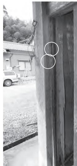
図11 東物置北西隅柱の土壁の貫仕口痕等
